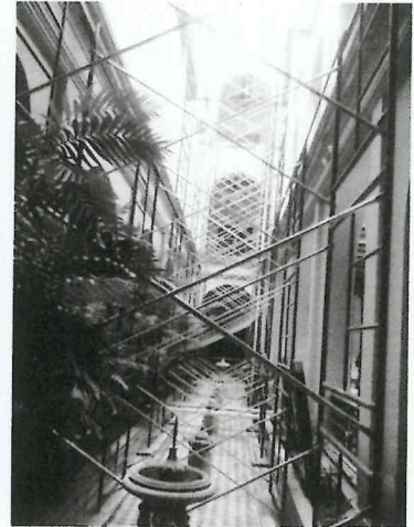
Colocación de los andamios sobre las Piletas para no dañar los trabajos de pintura realizados en los muros.
