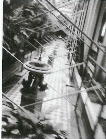
Colocación de los andamios sobre las Piletas para no dañar los trabajos de pintura realizados en los muros.
